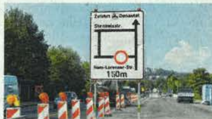
Die Baustelle an der Kastbrücke
